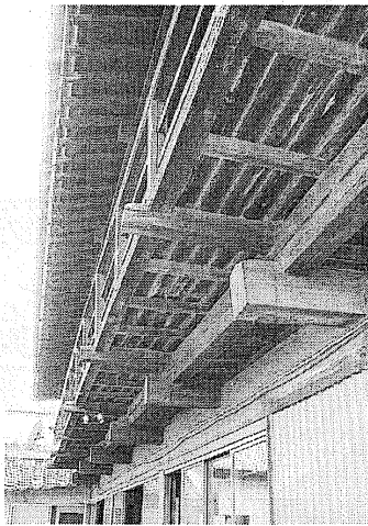
【写真6】 出し梁と欄干を見る
