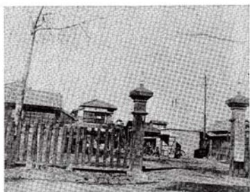
写真4-17 大衆に一時占拠された警察署の建物
